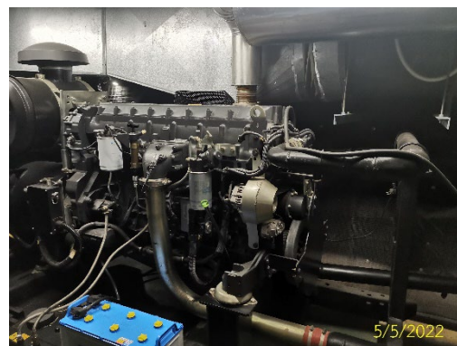
ภาพที่ 1.3.6-2 ระบบไฟฟ้าสำรอง
