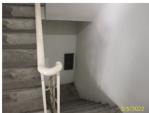
ช่องระบายอากาศบันไดหนีไฟ
