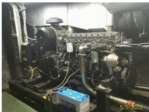
ภาพที่ 1.3.6-2 ระบบไฟฟ้าสำรอง
